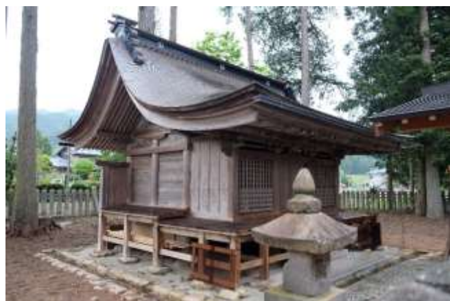
国指定重要文化財荒城神社本殿
